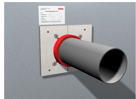
7. Die Rohrabschottung an gut sichtbarer Stelle kennzeichnen.
