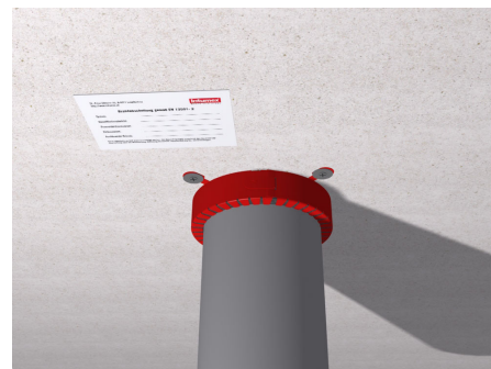
6. Die Abschottung an einer gut sichtbaren Stelle kennzeichnen.
