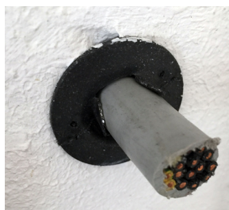
Exemple de câble dans le manchon Intumex® KH21
