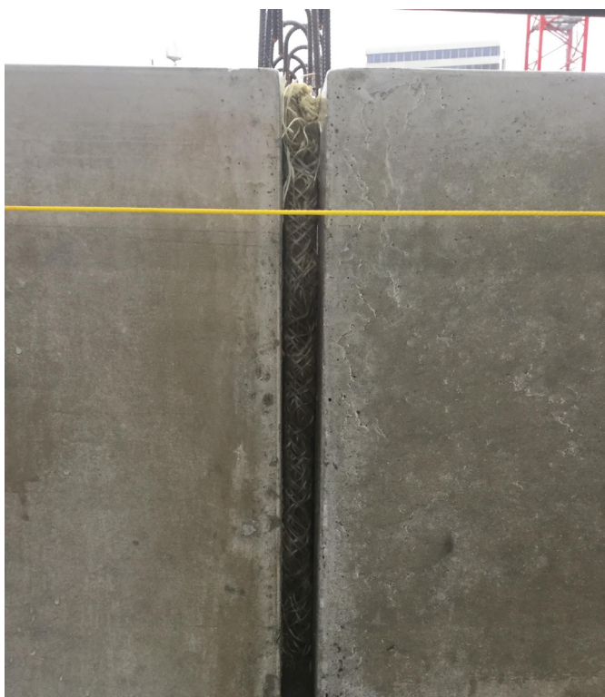
RF1 Brandschutzfuge mit der Fugenschnur SG300 zwischen Beton-Fassadenelementen.
