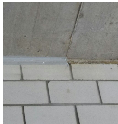
Joint Intumex® AS EI90 par revêtement de la laine minérale déjà mise en place
