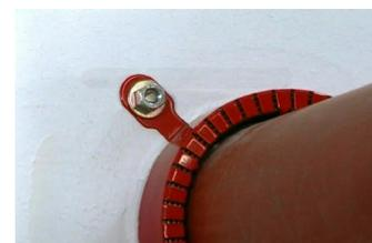
Brandschutzmanschette Intumex® RS10 um das Rohr mit den vorgeesehenen Laschen montieren und am Untergrund befestigen
