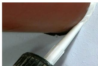
Zuerst mit Brandschutzmasse Intumex® AN den Ringspalt verschliessen
