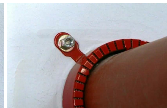
Ensuite mettre la manchette coupe-feu autour le tube et la fixer dans le fond avec des vis jointes
