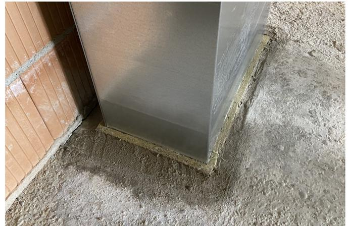
Aussparungen von Lüftungsleitungen verschlossen mit dem Brandschutzmörtel PROMASTOP®-M mit Brandverhalten RF1.
