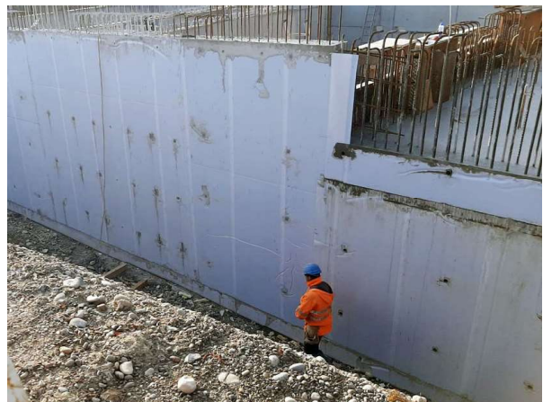
Abdichtungsfolie Ecotight Plus auf Wand Feuille d'étanchéité Ecotight Plus sur paroi Stuoia impermeabile Ecotight Plus sul muro
