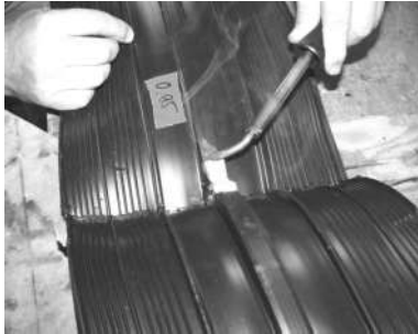
Schweißungsarbeit im Atelier und auf der Baustelle.
