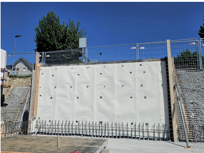
Anwendung der ECOTIGHT PLUS Folie bei einer Wandetappe auf der Schalung.
