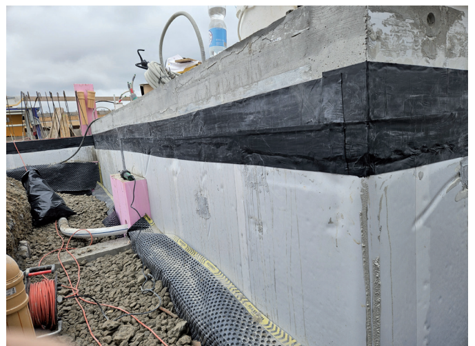
Anwendung der ECOTIGHT PLUS Folie als vollflächige Wandabdichtung mit oberseitigem Abschluss mit ECOTIGHT PLUS Outside Tape und abgeklebten Bindstellen.
