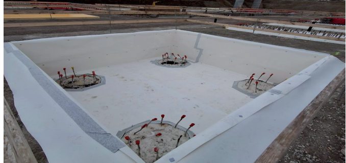
Anwendung der ECOTIGHT PLUS Folie in einer Bodenplattevertiefung mit Anschluss an Bohrpfähle. Die Stösse wurden mit ECOTIGHT PLUS Inside Tape verklebt.
