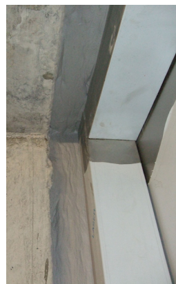
Rauchdichte Fuge RF1 mit Intumex® AS Fugenelementen
