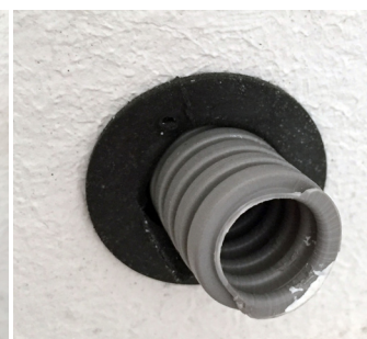
Exemple d'un conduit de câble dans le manchon Intumex® KH21
