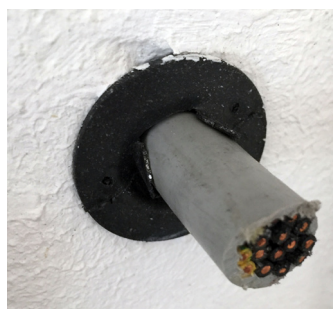
Exemple de câble dans le manchon Intumex® KH21
