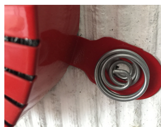
Montage rapide et facile: manchettes coupe-feu Intumex® fixées dans le panneau de laine de roche avec des vis en spirale.
