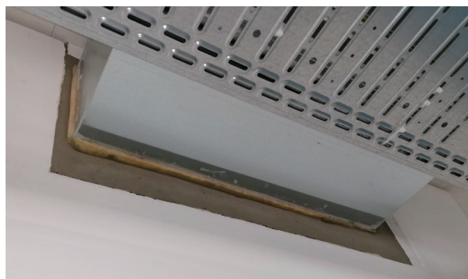
Beispiel eines Lüftungsschachtverschlusses nach VKF-Brandschutzrichtlinie 25-15, Ziff. 3.7.8.
