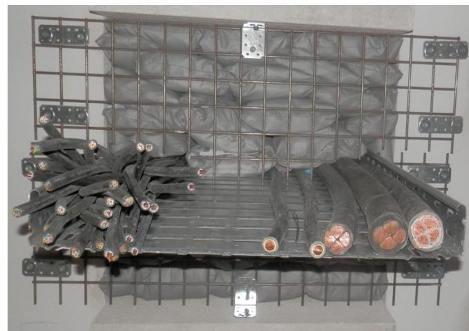
Promastop®-S/-L coussins coupe-feu: obturation dans le plafond. Les coussins coupe-feu doivent être soutenus en dessous par une grille métallique. Le câble et le chemin de câbles doivent être suspendus au-dessus à un maximum de 250 mm du plafond.
