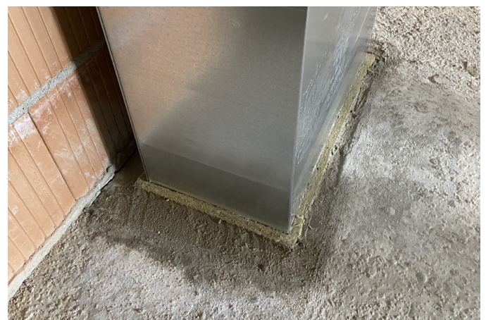
Conduites de ventilation, fermées avec le mortier coupe-feu Promastop®-M ayant une réaction au feu RF1.
