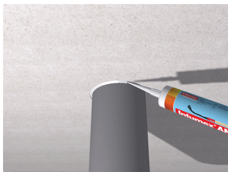
4. Den Ringspalt (max. 5 mm) mit Intumex® AN in einer Mindestdiefe von 20 mm verfüllen.
