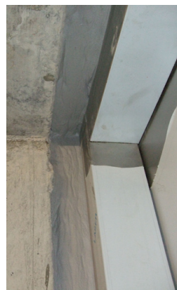
Rauchdichte Fuge RF1 mit Intumex® AS Fugenelementen
