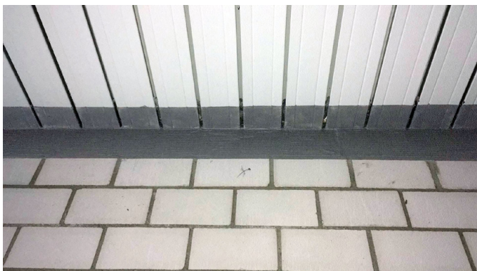
Beispiel eines Trapezblech-Anschlusses mit Intumex® AS.
