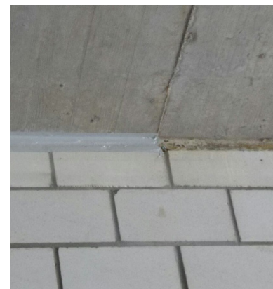
Intumex® AS EI90 Fuge mittels Beschichten der schon vorhandenen Steinwolle
