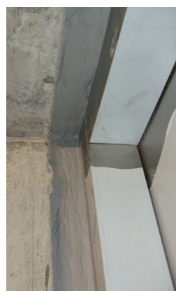
Joint RF1 étanche à la fumée avec éléments de joints Intumex® AS
