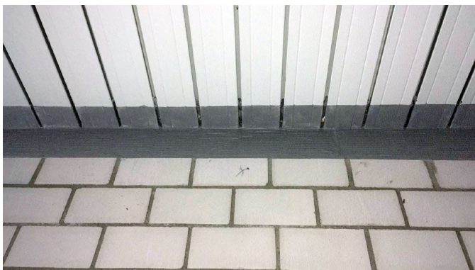
Exemple d'un raccord de tôle trapézoïdale avec Intumex® AS.
