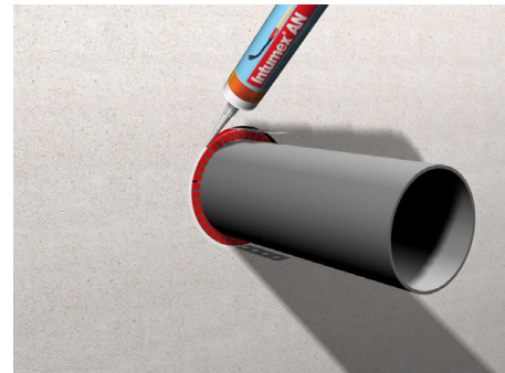
6. Den Ringspalt zwischen Wand und Manschette mit Mineralwolle RF1 und mindestens 5 mm Intumex® AN ausfüllen.
