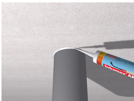
4. Den Ringspalt (max. 5 mm) mit Intumex® AN in einer Mindesttiefe von 20 mm verfüllen.
