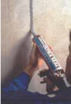
Aufbringen der quellfähigen Dichtungsmasse Adeka P-201
