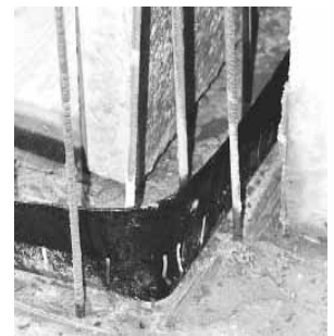
im Eckbereich einfach umbiegen, hier bereits einbetoniert.
