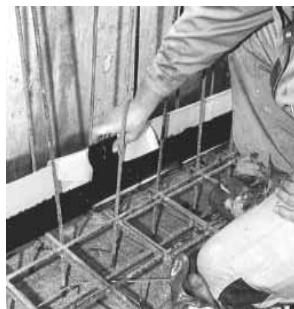
Verbindungsstelle mit Klemmbügel sichern
