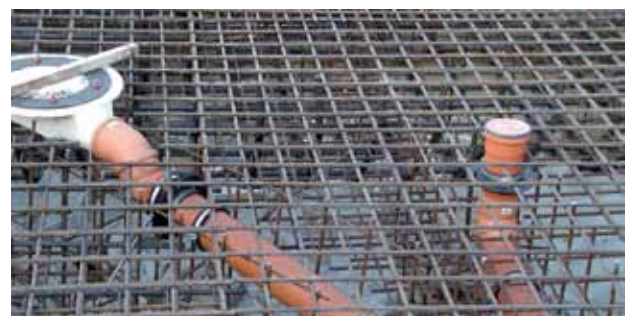
Mauerkragen in Bodenplatte
