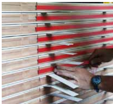
Intumex Brandschutzlaminat Typ LPSK rot, Montage in vorgefräste Nut
