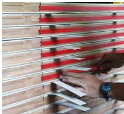
Laminé coupe-feu INTUMEX, type LPSK rouge, montage dans rainure fraisée
